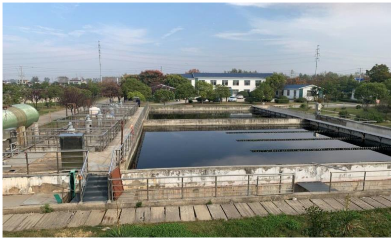
图 3.1-7 混凝沉淀池现状
