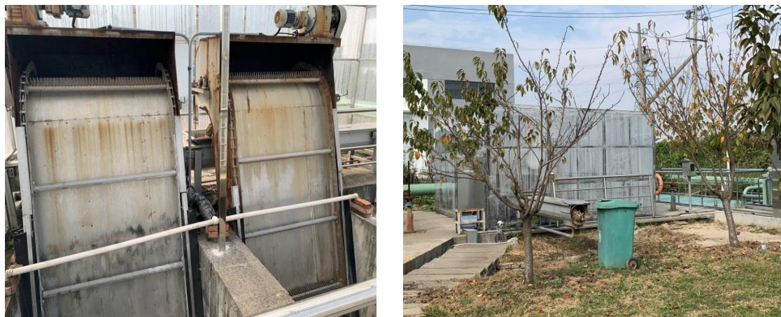
图 3.1-3 粗格栅及提升泵房现状
