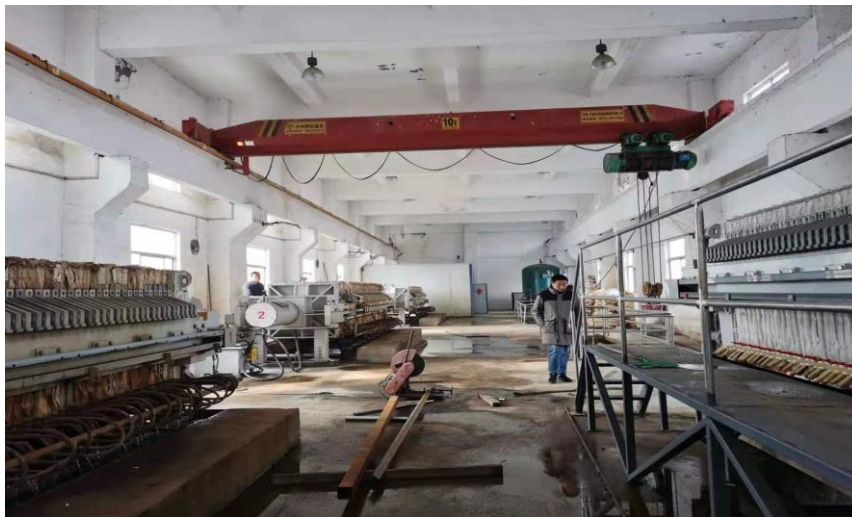
图 3.1-10 污泥脱水机房及加药间现状
